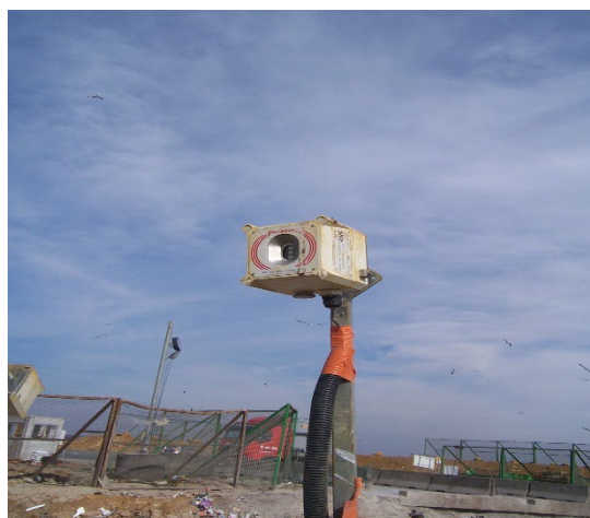
Photo 8 – Point de pompage pour les sapeurs-pompiers et détecteur de départ de feu
