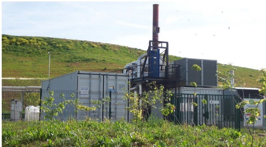
Photo 2 – Moteur de valorisation électrique
