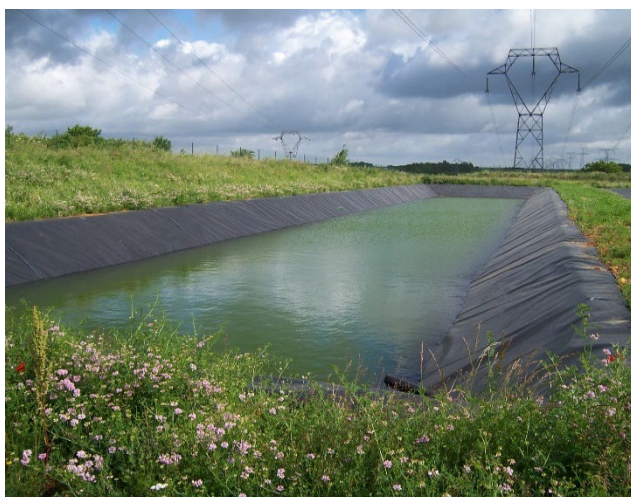
Photo 6 – Bassins de stockage des condensats
