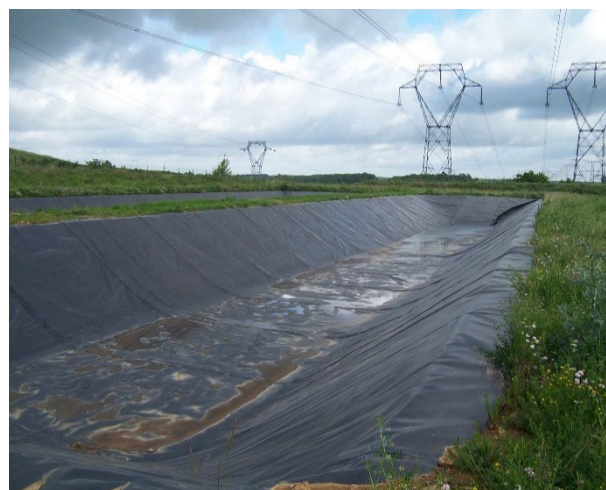
Photo 6 – Bassins de stockage des condensats
