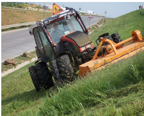
Photo 9 – Opération de fauchage des talus
