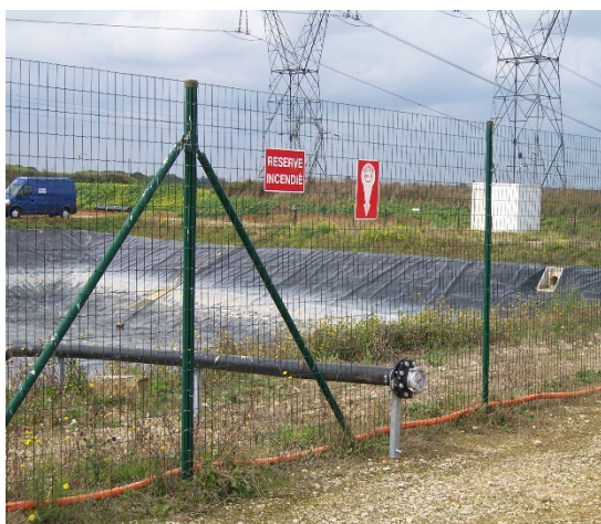
Photo 8 – Point de pompage pour les sapeurs-pompiers et détecteur de départ de feu
