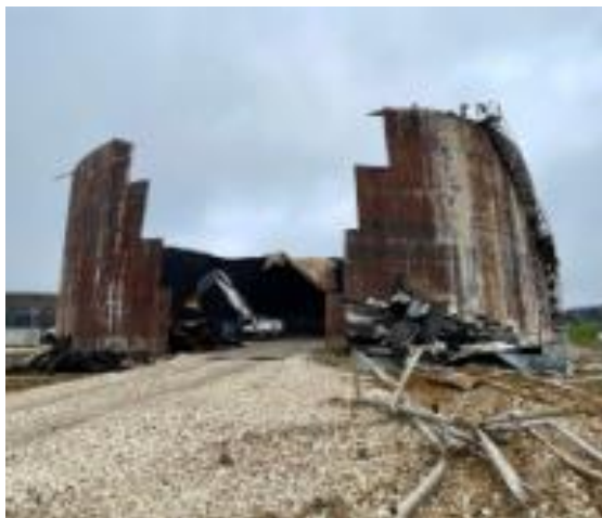
Démantèlement de bac
