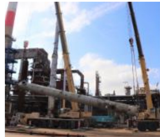
Dépose de colonne unité HDS (démantèlement 'chirurgical')
